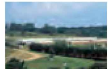
Mitutoyo Sul Americana Ltda. Factory (Suzano)
